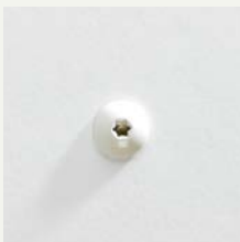
Standaard schroefkop gebruikt met andere bekledingsmaterialen
