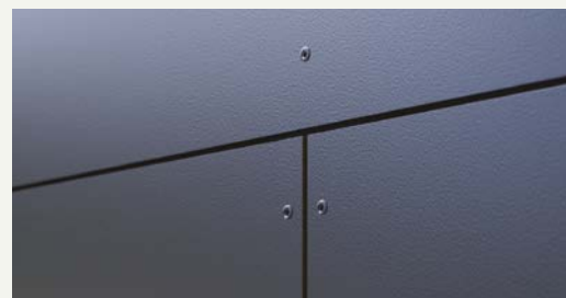
1. Rockpanel: Hoge dimensionale stabiliteit maakt smalle voegen tussen de panelen mogelijk.
